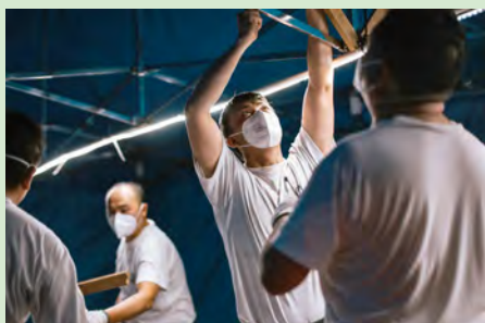
搭建臨時指揮站 Criação de posto de comando provisório
