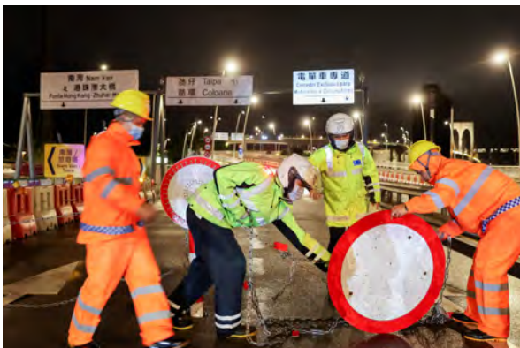
封閉跨海大橋 Encerramento das pontes Macau-Taipa
